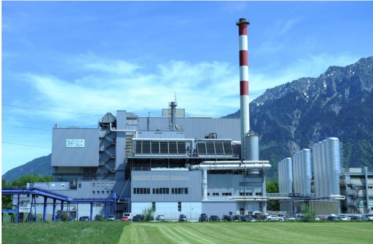
Abbildung 7-1: KVA Buchs (SG) mit den 12 Wärmespeichern (rechter Bildrand)
