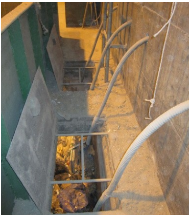
Figure 1 : Distribution des cendres traitées par lavage acide sur toute la largeur de la trémie de remplissage de la ligne de four «Re-Fire» via quatre conduites
