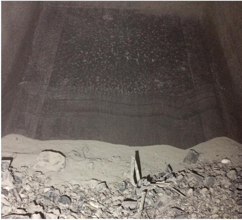
Blick ins Innere eines Schlackencontainers (aufgekippt auf der Entleerstation)
