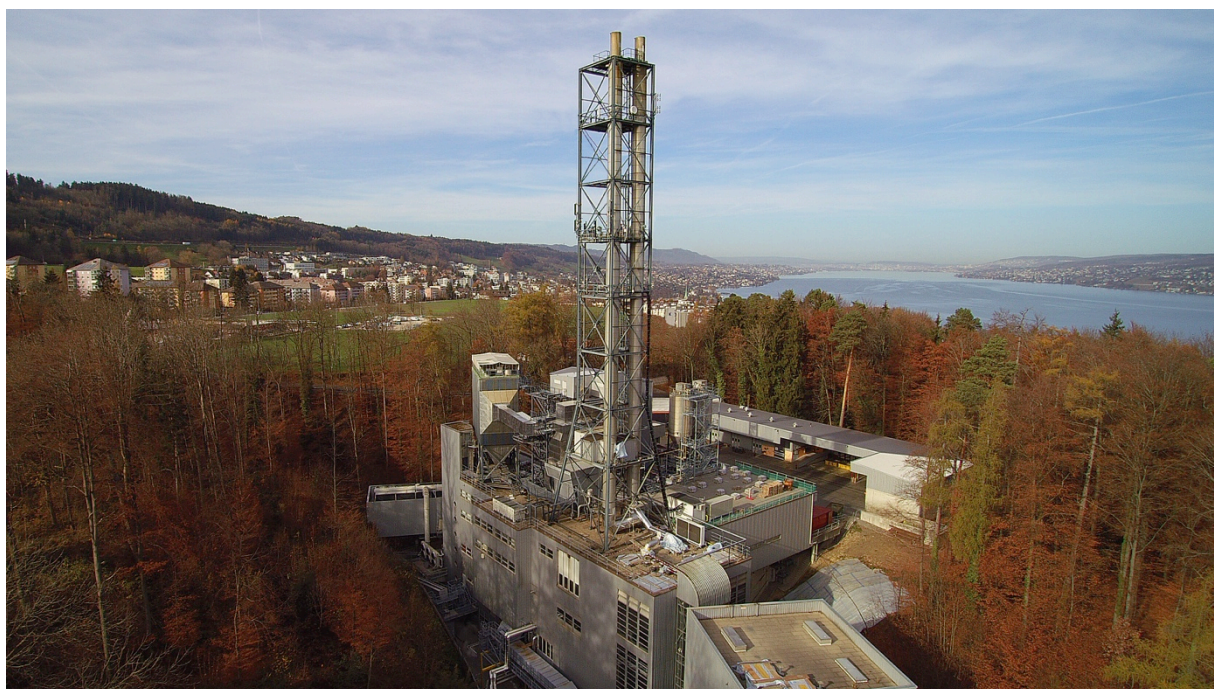
Abbildung: KVA Horgen: 2017 ist erstes Jahr Vollbetrieb nach Umbau auf eine Ofenlinie und mit neuer Turbine (Quelle: ZVHO, © Public Voice, Adligenswil)
