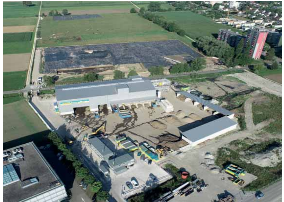
Drohnenaufnahme: zur Verfügung gestellt von Bauherrngemeinschaft Sanierung Stadtmist Solothurn
